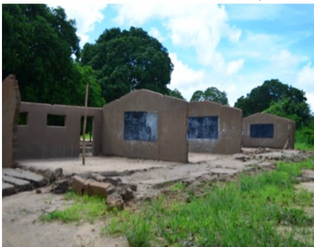
Sala de aulas antes do OP em Namicopo
